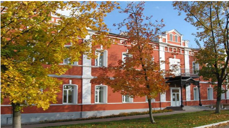
Здание трехклассного училища (ныне корпус хирургии ЦРБ).
